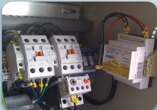
Подключение шлюза Netbiter к панели управления осуществляется через внутреннюю сеть с протоколом Modbus.
